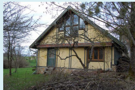
Vue de derrière
